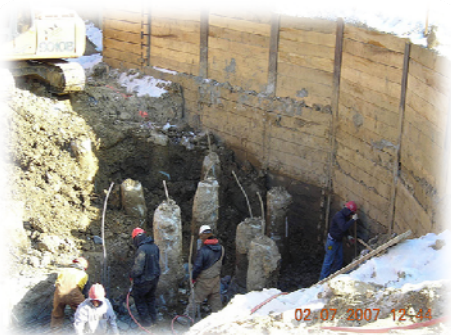
Mini pile foundations
