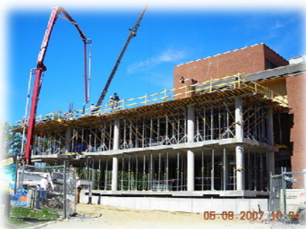
Concrete slab & column pour
